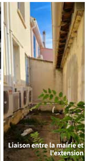
Rénovation des bureaux de la mairie
