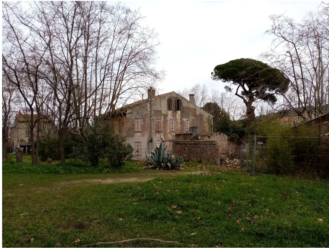
Vue sud du Bâtiment dans son environnement
