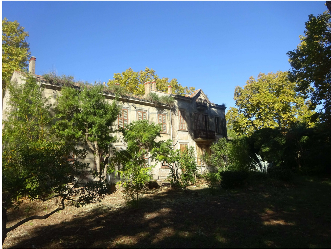
Vue principale Est du Bâtiment dans son environnement
