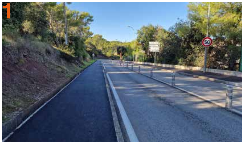
1 De part et d'autre de la RD 18 au niveau de « Vert Bois » pose d'enrobé sur les trottoirs.
