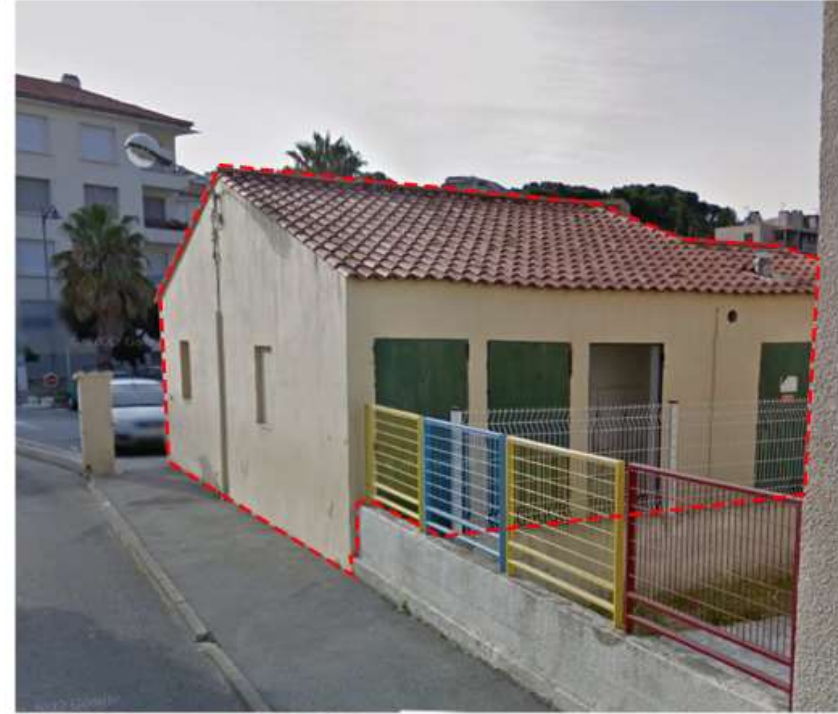
Photo PD3-3 _ vue depuis la rue des Ecoles
