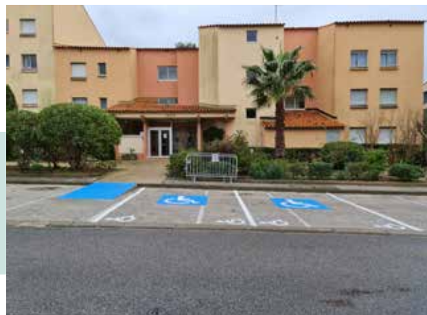
Emplacements PMR Immeuble Lagos
